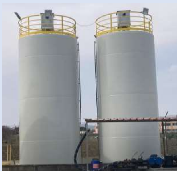
Serbatoi di stoccaggio rifiuti oleosi ed emulsioni stabilimento di Orvieto
